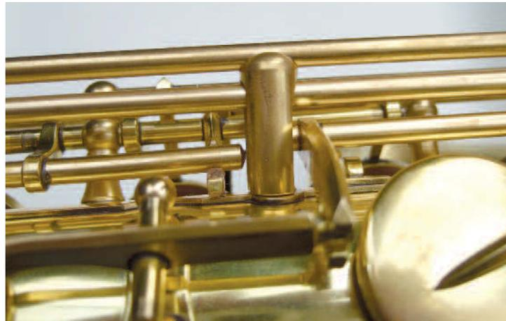
Gut: schraubenlose Führung für die langen Achsen
